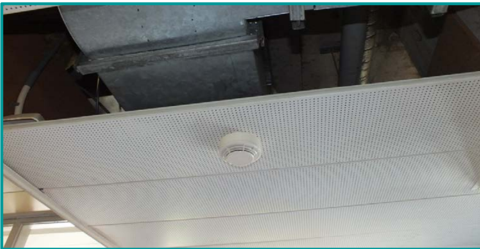
Foto : verlaagd plafond open bij rookmelder
