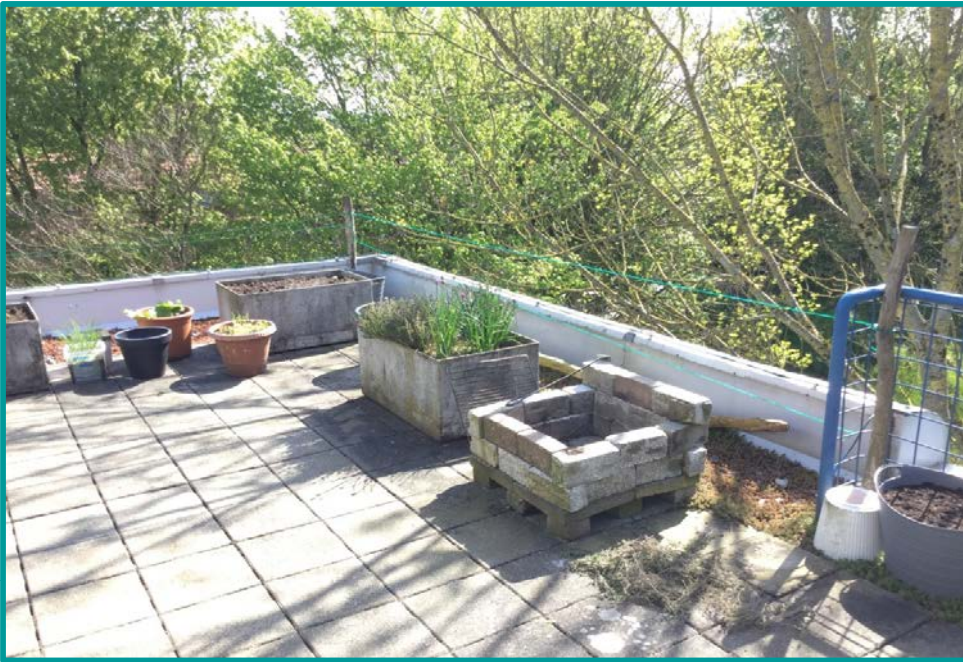
Foto: dakterras op 2e verdieping
