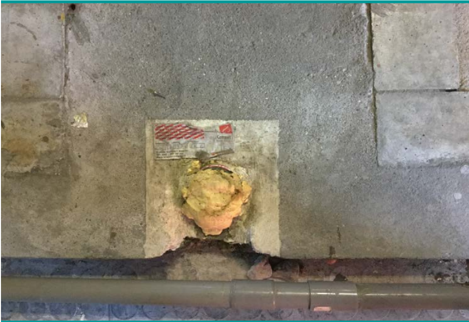
Foto: brandwerende doorvoeren
