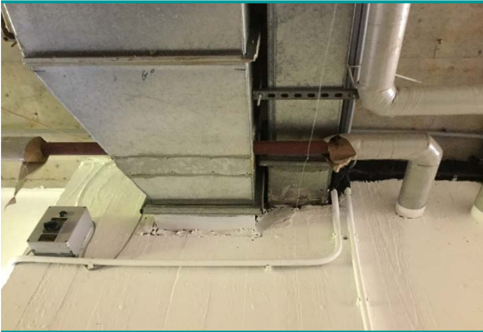
Foto: installatie onderdelen in brandscheiding
